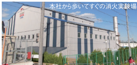
本社から歩いてすぐの消火実験場
