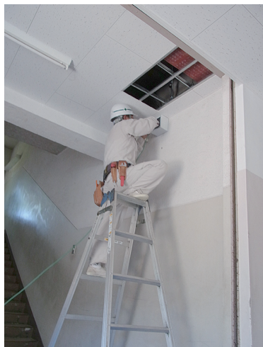
▲通線工事の様子
