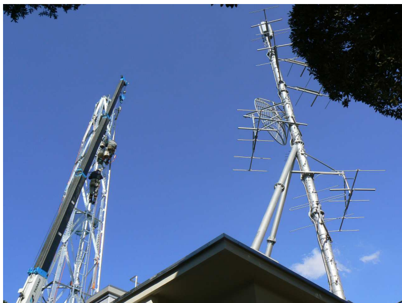
左側が今回新しく建設中のデジタル放送用のアンテナの鉄塔 右側は現在使用中のアナログ放送用のアンテナ(鉄塔)
