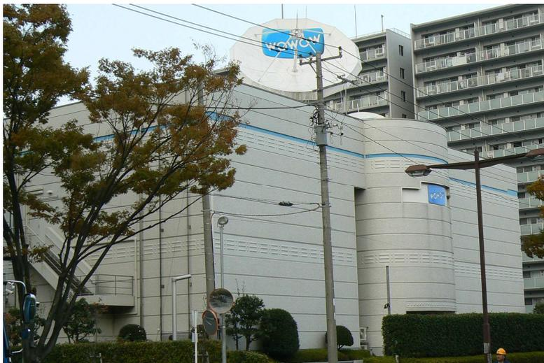
屋上にある直径7.6mのアンテナ(写真左上)は、赤道上空36,000kmの衛星に向けてBSアナログ放送を行っています。このパラボラの厚みは積雪時に雪を溶かすための温風が流れる仕組みからとのこと。なるほど！
