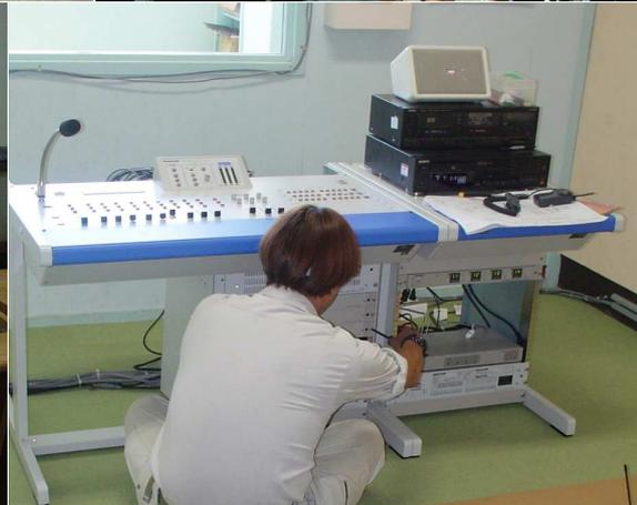
音声調整卓の入替え前(写真左)と入替え後(下右)。こちらの親時計から自動的にチャイムユニットへ制御信号を送りチャイムを鳴らしています。
