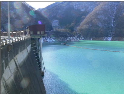
ダムの外側。写真左側にある茶色い箱のようなものが放流ゲート
