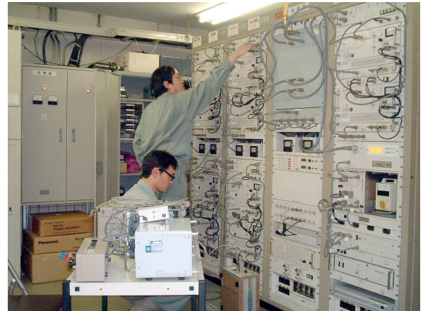
秦野中継局の定期点検作業
