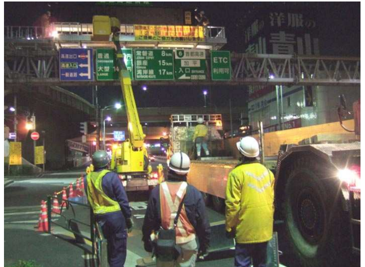
首都高速道路川口線・安行付近の可変規制速度標識（電光掲示板）の設置工事
