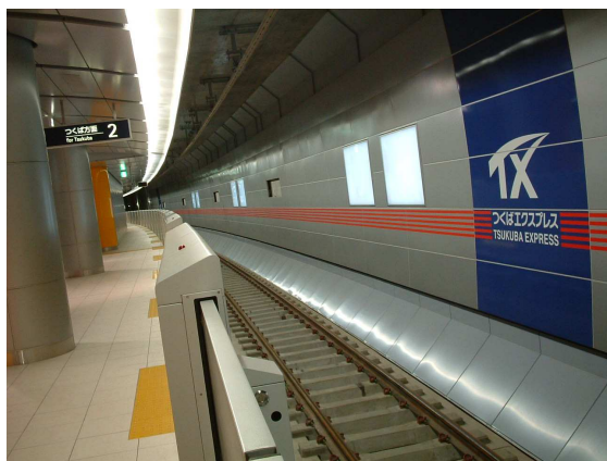
ホームも、線路の壁をパネルで化粧しているのでコンクリートが見えなくてスッキリしている。
