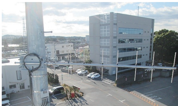
アンテナの交換、ケーブル敷設、端末接続工事
