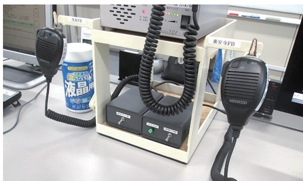
無線機設置及び配線接続工事
