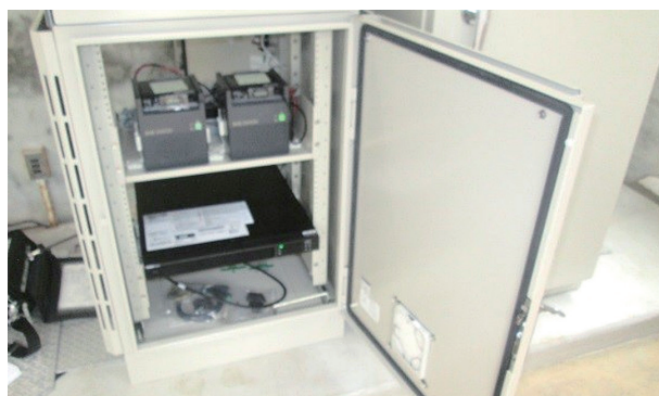
機器の設置及び配線接続工事
