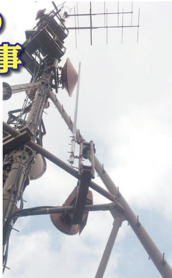
放送事業用連絡無線は、放送局と山の上の中継局を専用線で結ぶことで、中継局を通して県内の広範囲な現場スタッフと連絡を取ることを可能にします。番組制作現場と中継現場の円滑な連絡を実現します。
