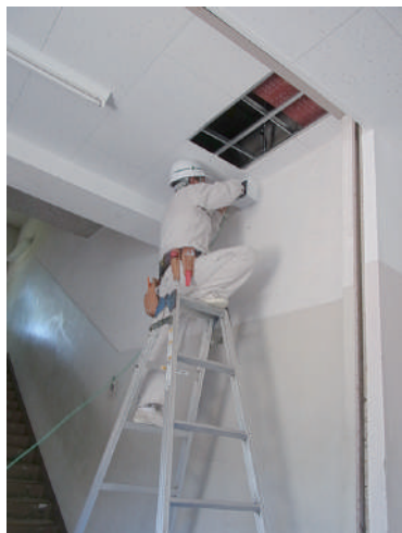
▲通線工事の様子
