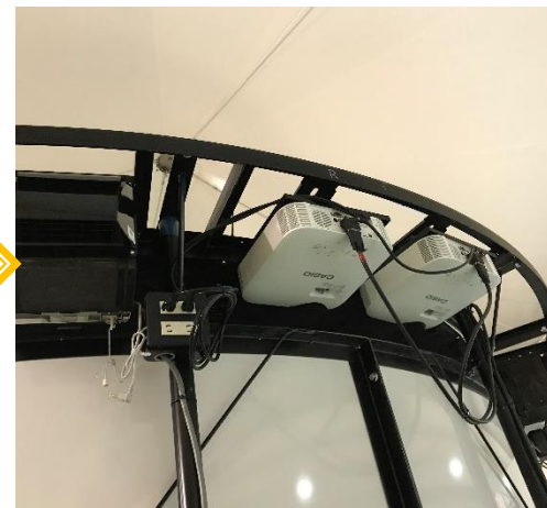
スクリーンパネル取付け、プロジェクター、PCなど機器設置
